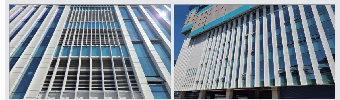
▲ 고층부 실외기실 외벽 그릴 마감 ▲ 고층부 외벽 마감 유리+AL+테라코타
