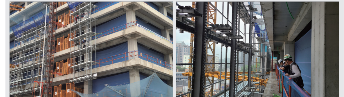
▲ 외벽 마감 가설재 신기술 SWC 설치 ▲ 외벽 마감 가설재 신기술 SWC 적용
